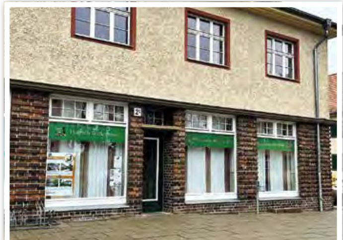
Die Bürgerbegegnungsstätte ist das vorübergehende Zuhause der Tafel für den Zeitraum der Baumaßnahmen.
