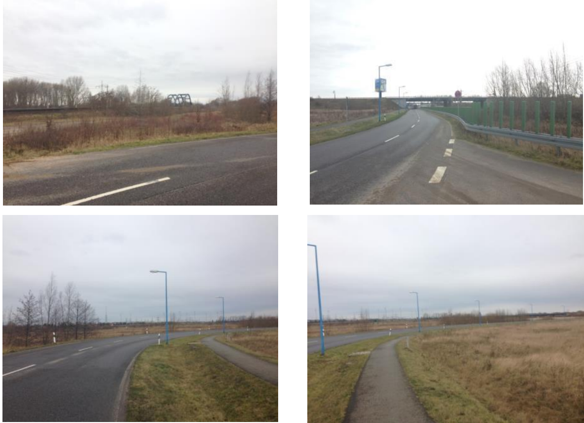
Abbildung 11 Photographische Bestandsaufnahme des Bebauungsplangebietes
