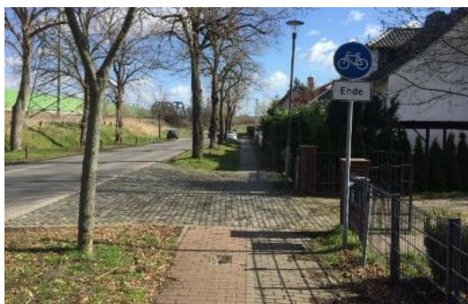
Abbildung 24: Unzureichend dimensionierter und plötzlich endender Radweg in der Zeetower Straße in Wustermark, südlich (Bild li.) und nördlich (Bild re.) der Lehrter Bahn
