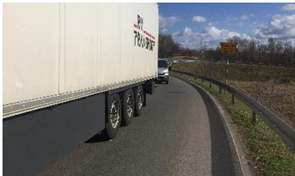
Abbildung 26: Gemischte Führung des Rad- und Kfz-Verkehrs mit zusätzlich gefährdender Leitplanke im Kuhdammweg – Zufahrt GVZ (Bild li.) und auf der Priorter Str. in Ri. Priort (Bild re.)
