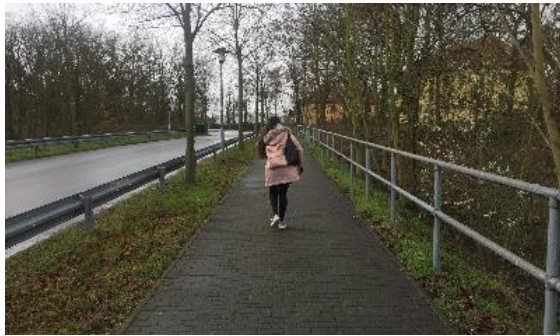
Abbildung 25: Gemischte Führung des Fuß- und Radverkehrs mit unzureichender Dimensionierung und mangelhafter Aufenthaltsqualität in der Bahnhofsstraße in Elstal (Bild li.) und Berliner Straße in Wustermark (Bild re.)
