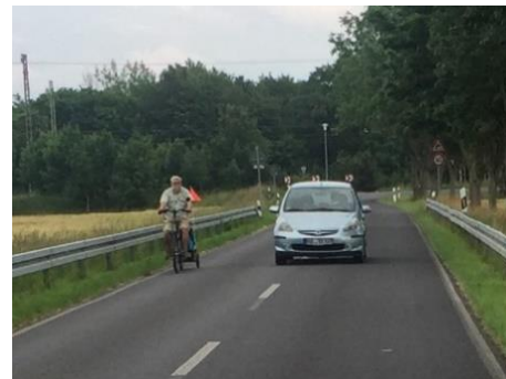
Abbildung 26: Gemischte Führung des Rad- und Kfz-Verkehrs mit zusätzlich gefährdender Leitplanke im Kuhdammweg – Zufahrt GVZ (Bild li.) und auf der Priorter Str. in Ri. Priort (Bild re.)
