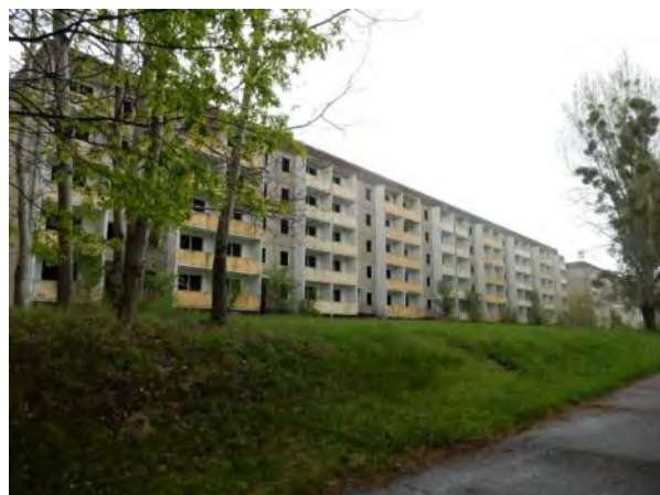
Abb. 19: Plattenbauten (vermutlich Typ WBS 70)
