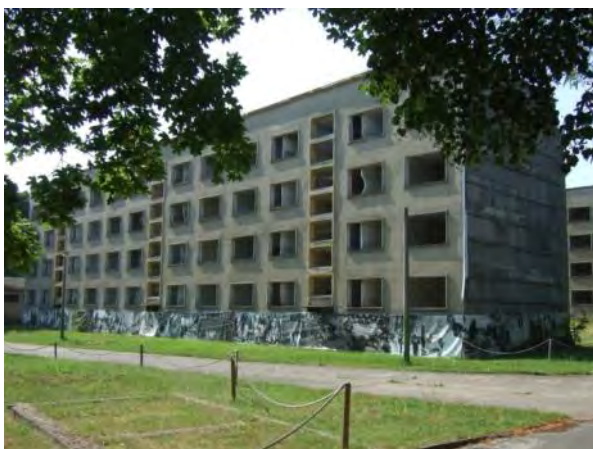
Abb. 18: Blockbauten vom Typ IW 64
