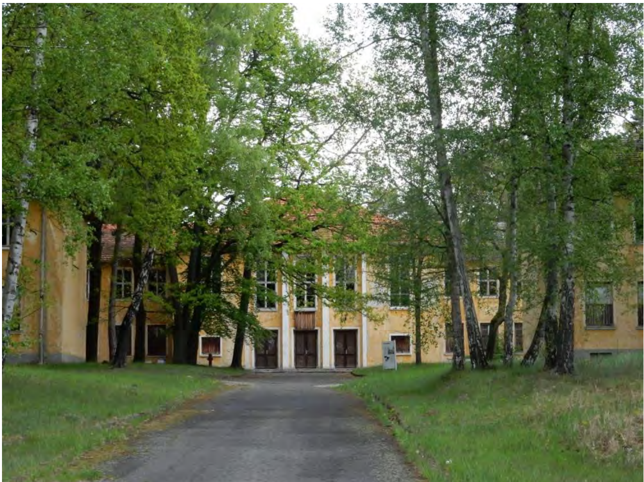
Abb. 9: Hindenburghaus aus westlicher Richtung
